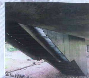
4-zijdig geslepen vluchttrap voor de Beneluxlijn vervaardigd door EN-287 gecertificeerde lassers.
