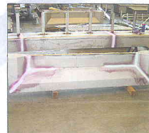
Penetrant onderzoek RVS Mig laswerk
